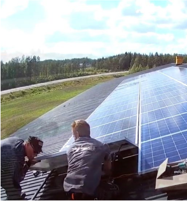
Kuva 3. Maatilarakennusten kattojen lappeet noin etelän suuntaan tarjoavat mahdollisuuden tuottaa aurinkosähköä omaan käyttöön (kuva: LVI-More Oy).
